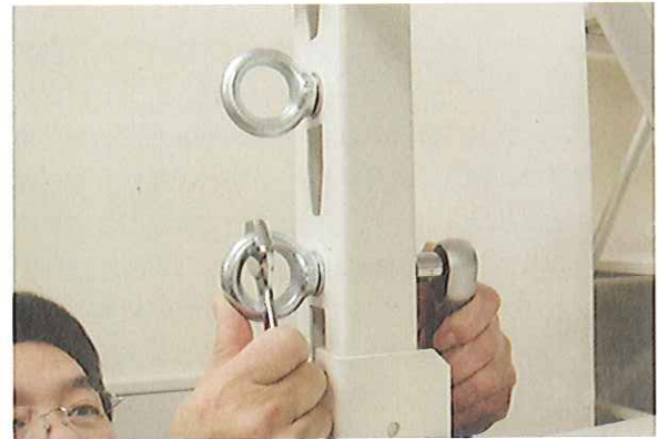
写真5 支持金具の取り付けの様子
