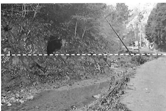
写真2 水害後の坑口周辺の様子 - 川両岸の樹木が除去されている（2013年11月14日）写真の坑口最下部と道路面の高さまで増水した（破線）。
