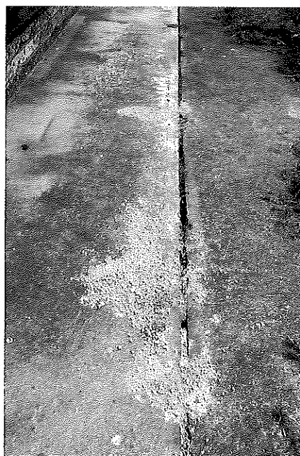
写真4 コンクリートの隙間に作られた巣(2010)
